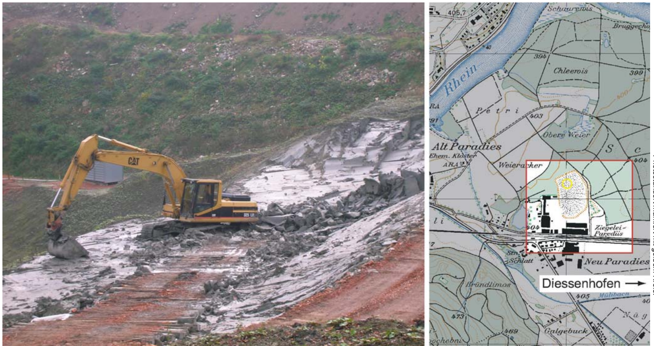
Abbau eines ehemaligen Seebodens für die Ziegelherstellung (Herbst 2006) – Situation 1:25'000
