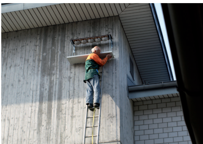
Abb. 5: Befestigung von Kunstnestern mit Kotbrett.
