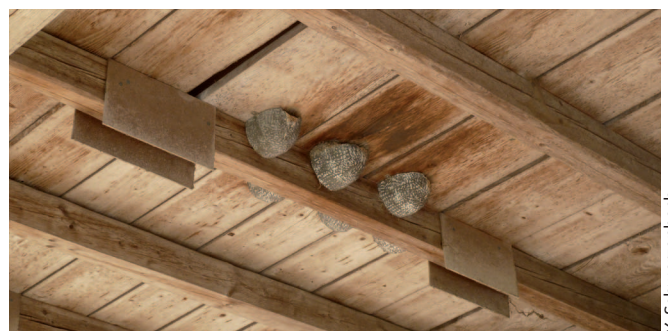
Abb. 16: An gefährdeten Standorten bieten Manschetten aus Pavatex oder Blech Schutz vor Prädatoren.
