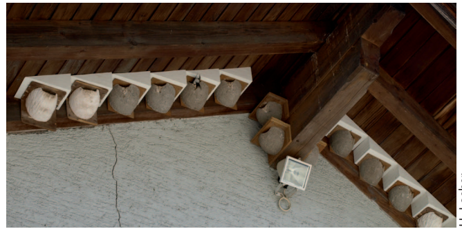
Abb. 15: Befestigung unter Schrägdach mithilfe von Holzkeilen.
