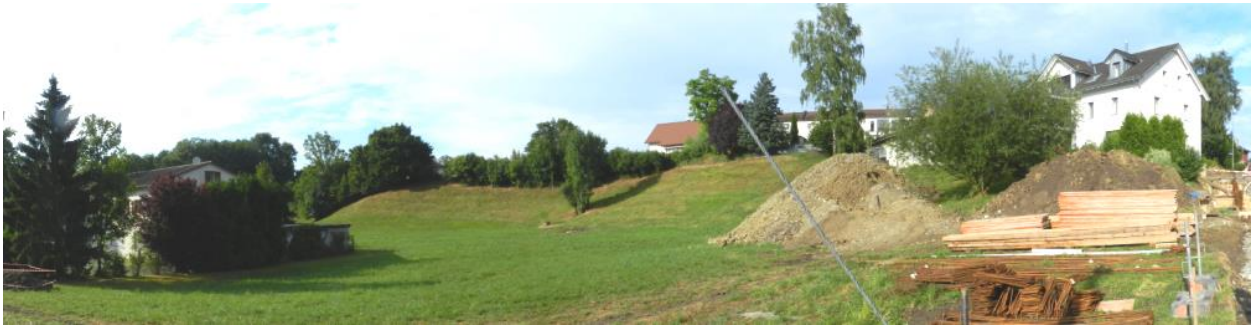
Südkante Schönenbaumgarten: Aushub: lehmiges Moränenmaterial.
